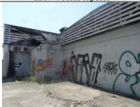
J1.4 – Bâtiments à l'arrière du site
