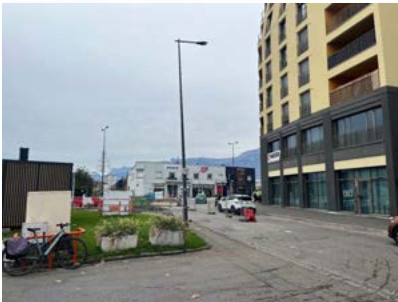
Eclairage public rue Julian Grimaud
