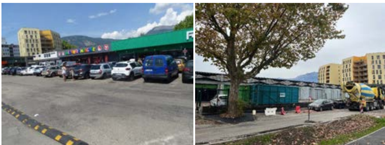
Bâtiments et parking du site ; Platane et grillages à l'arrière du site
