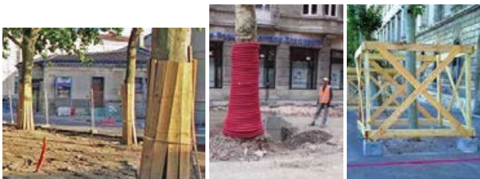
Exemples de protections des arbres
