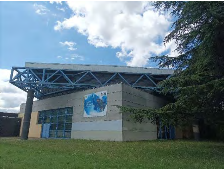
Figure 62 : Salle de spectacle L'Heure Bleue, à l'est du site (visite SCE du 22/07/24)
