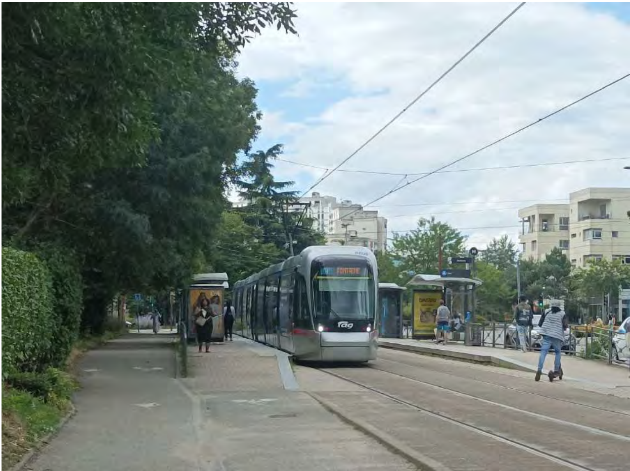
Figure 94 : Arrêt de tram de la ligne A
