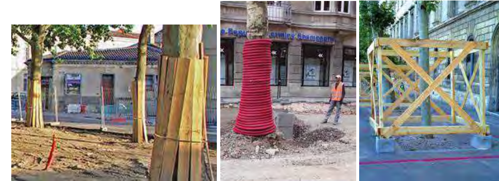
Exemples de protections des arbres
