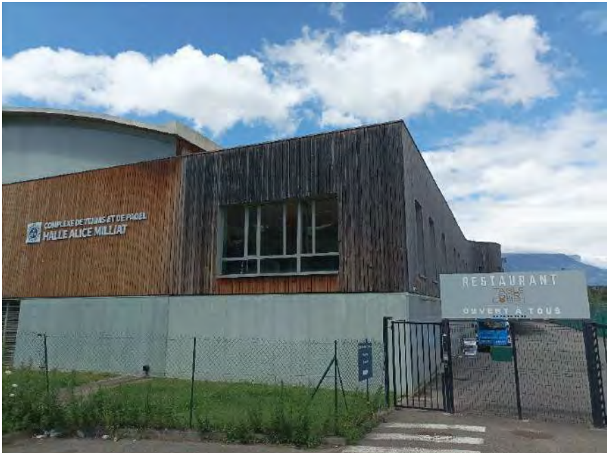
Figure 61 : Complexe de tennis et padel au nord-est du site (visite SCE du 22/07/24)
