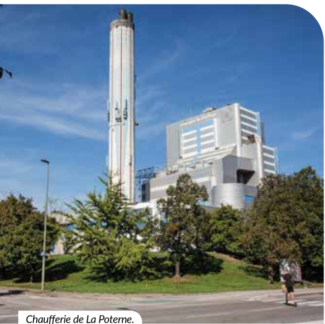
Chaufferie de La Poterne.
