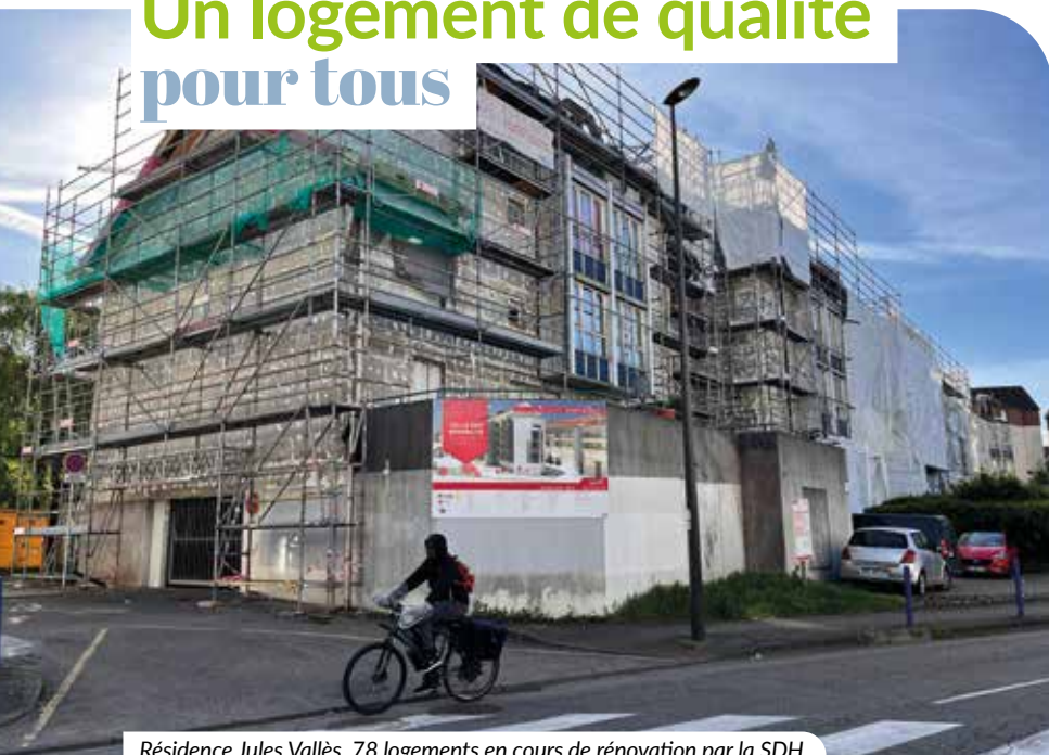
Résidence Jules Vallès, 78 logements en cours de rénovation par la SDH.
