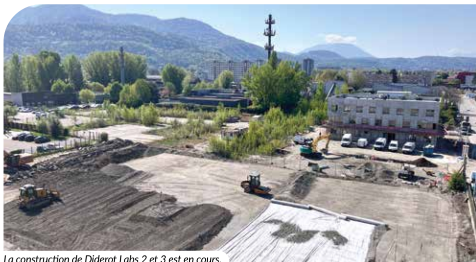
La construction de Diderot Labs 2 et 3 est en cours.
