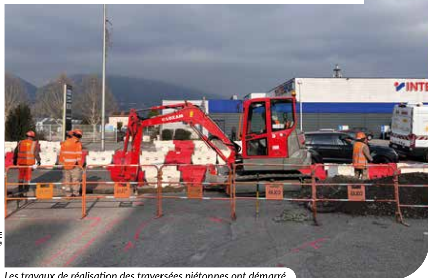
Les travaux de réalisation des traversées piétonnes ont démarré.
