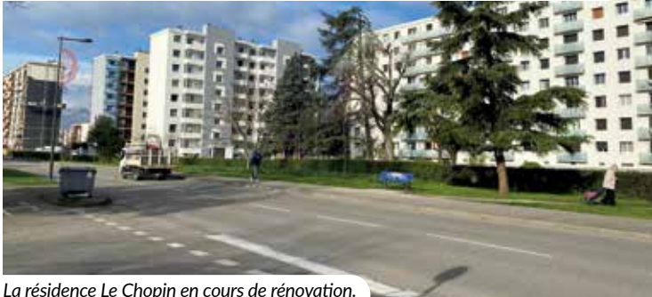
La résidence Le Chopin en cours de rénovation.
