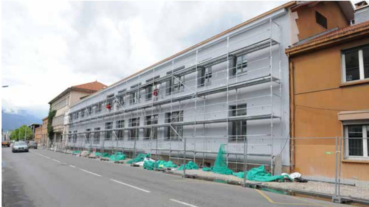
Les travaux reposent sur la sûreté des lieux, l'amélioration thermique et la mise en accessibilité du bâtiment, à l'intérieur et à l'extérieur. La réfection des façades, qui correspond au chantier le plus important, a débuté au mois de mars. Six tranches ont été définies pour mener à bien les travaux, phase par phase. Aujourd'hui, la tranche 1 est quasiment terminée. Les menuiseries à rupture de pont thermique équipées de double vitrage (fenêtres et portes)
