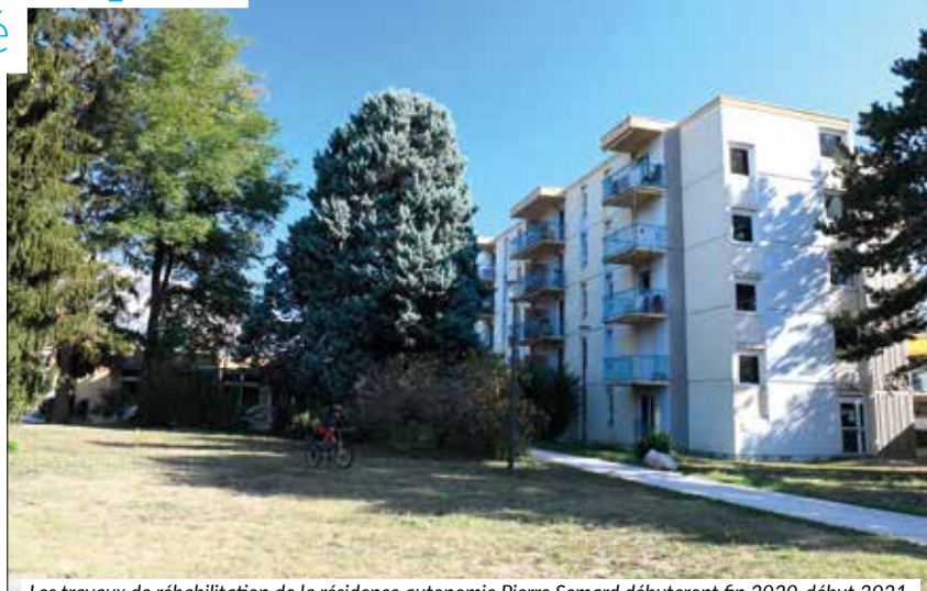
Les travaux de réhabilitation de la résidence autonomie Pierre Semard débiteront fin 2020-début 2021.
