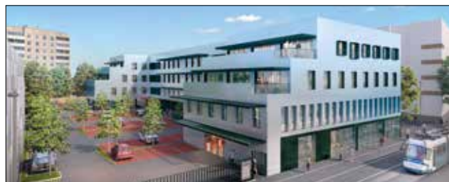
À côté du Pôle hôtelier, un bâtiment tertiaire de 5 000 m 2 hébergera des entreprises en lien avec le Domaine universitaire et la recherche appliquée.
