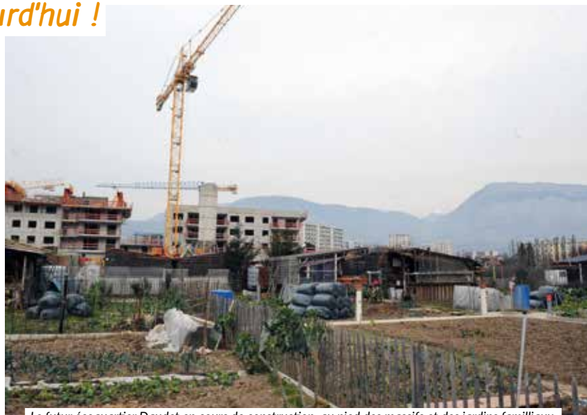
Le futur écoquartier Daudet en cours de construction, au pied des massifs et des jardins familiaux.
