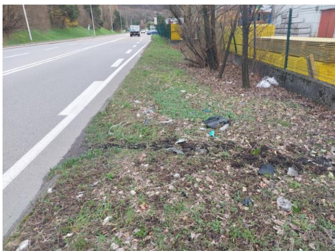
Figure 22 : Caniveau d'évacuation à nettoyer
