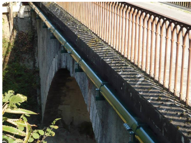
Figure 21 : Exemple de canalisation en encorbellement
