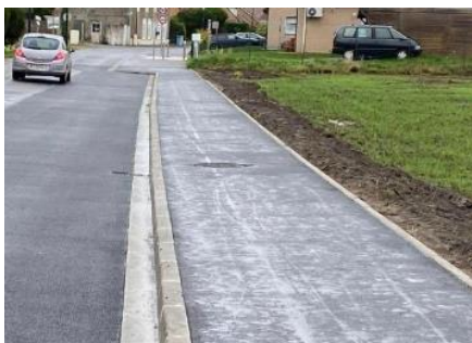
Figure 12 : Chaussée en enrobés
