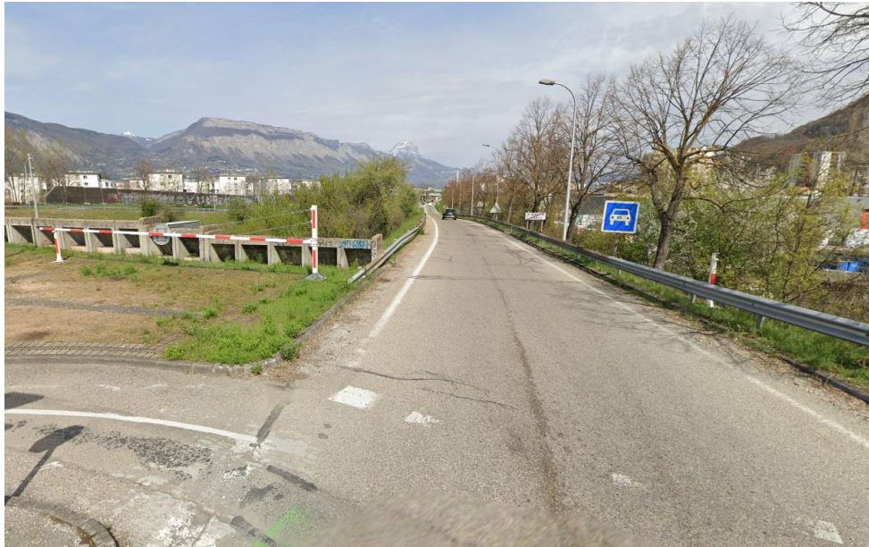
Figure 25 : Barrière de l'entrée en direction de Chambéry
