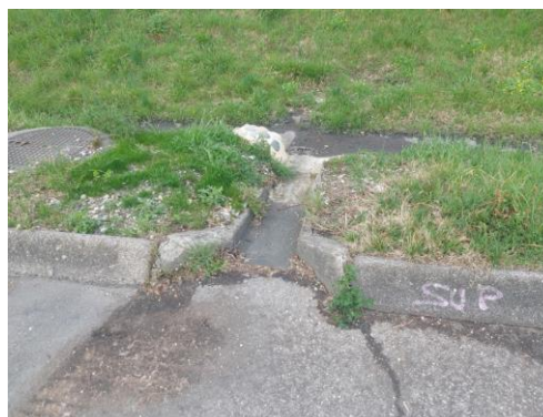
Figure 5 : Ouverture pour évacuation des eaux pluviales
