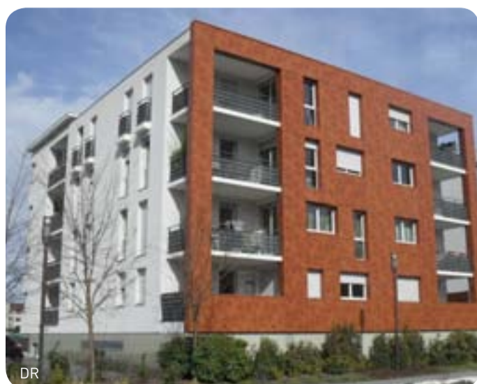
■ Immeuble de 4 étages, Zac Centre, SMH
