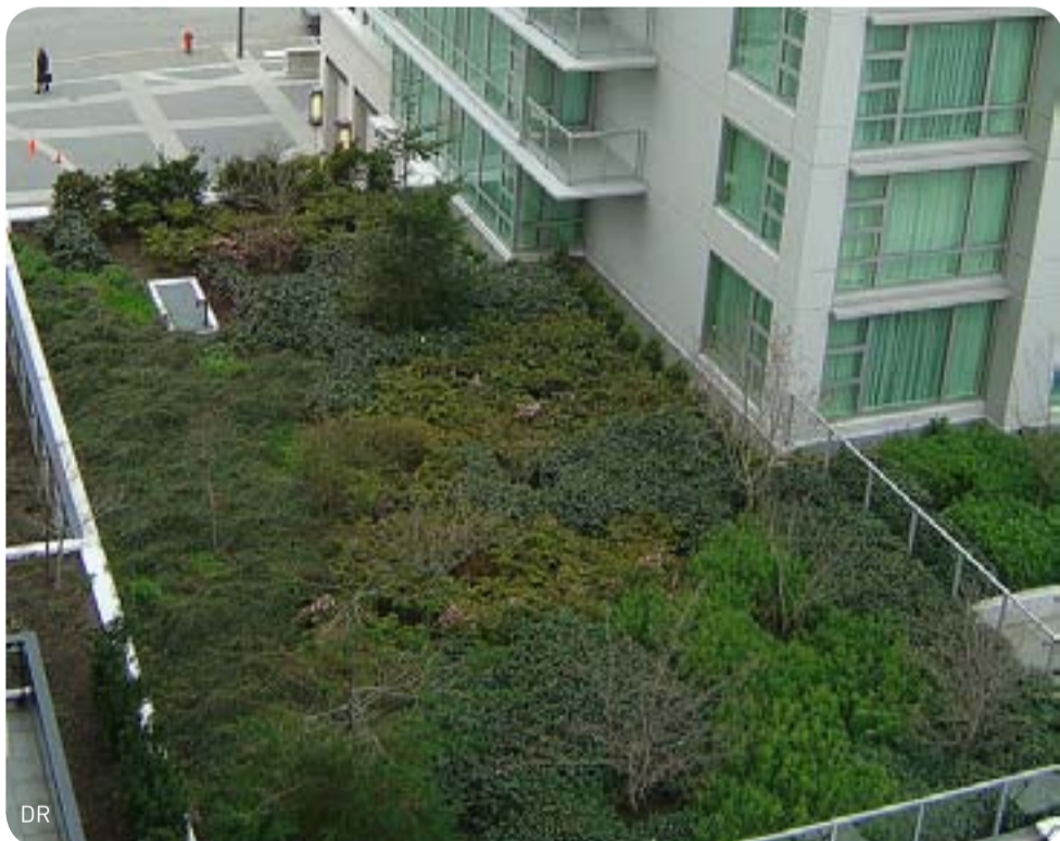
■ Végétalisation des dalles de garage, Canada.
