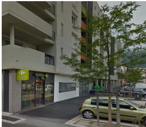
TRAITEMENT DES RDC COMMERCIAUX
