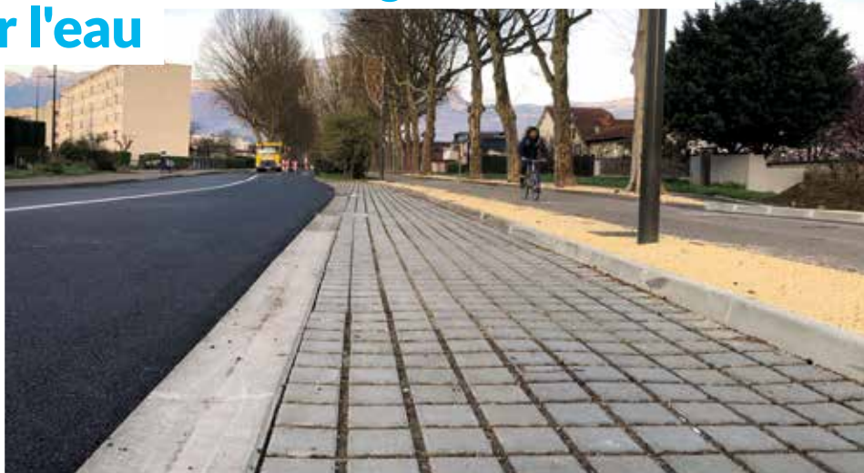
Places de stationnement revêtues de pavés fertiles avenue du Bataillon Carmagnole-Liberté.
