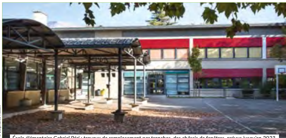
École élémentaire Gabriel Péri : travaux de remplacement par tranches, des châssis de fenêtres, prévus jusqu'en 2023.
