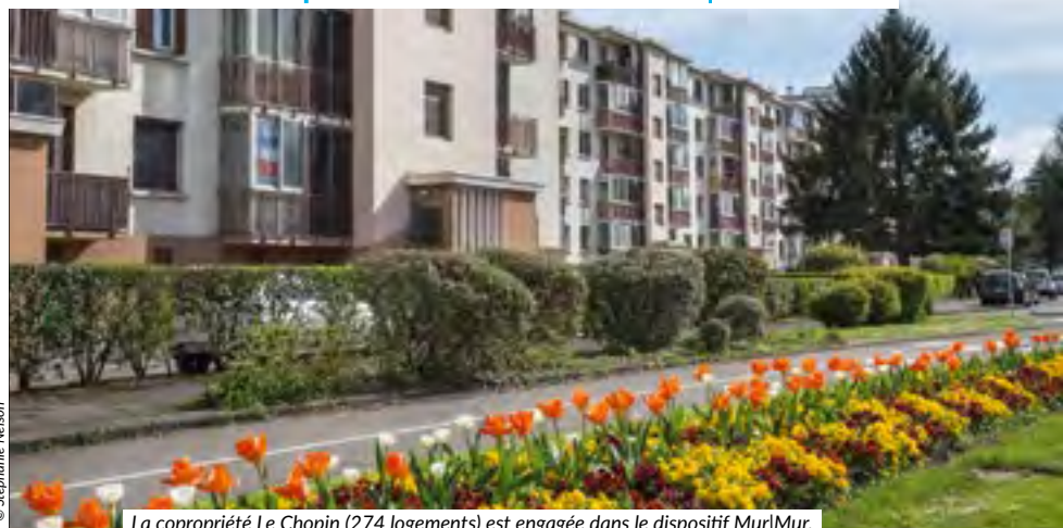
La copropriété Le Chopin (274 logements) est engagée dans le dispositif Mur|Mur.
