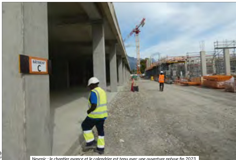
Neyrpic : le chantier avance et le calendrier est tenu avec une ouverture prévue fin 2023.
