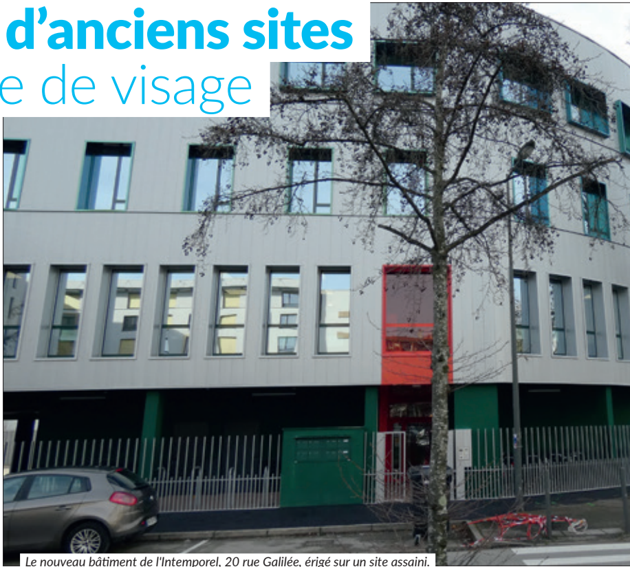
Le nouveau bâtiment de l'Intemporel, 20 rue Galilée, érigé sur un site assaini.
