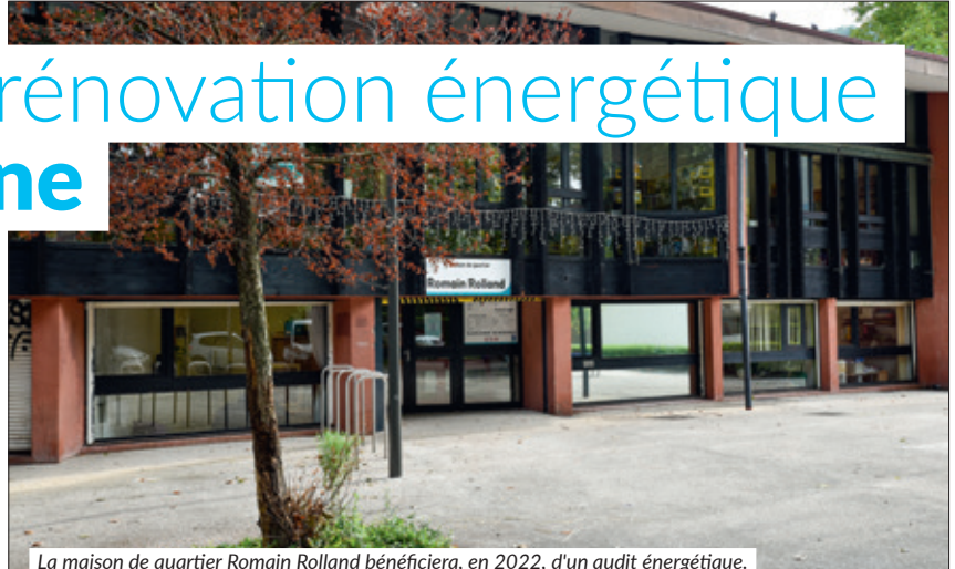
La maison de quartier Romain Rolland bénéficiera, en 2022, d'un audit énergétique.
