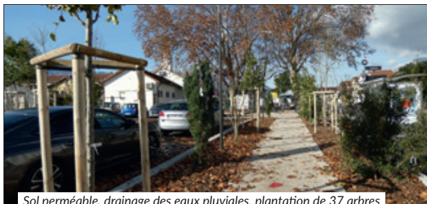
Sol perméable, drainage des eaux pluviales, plantation de 37 arbres sont, entre autres, la signature du nouveau parking de la place Paul Eluard.
