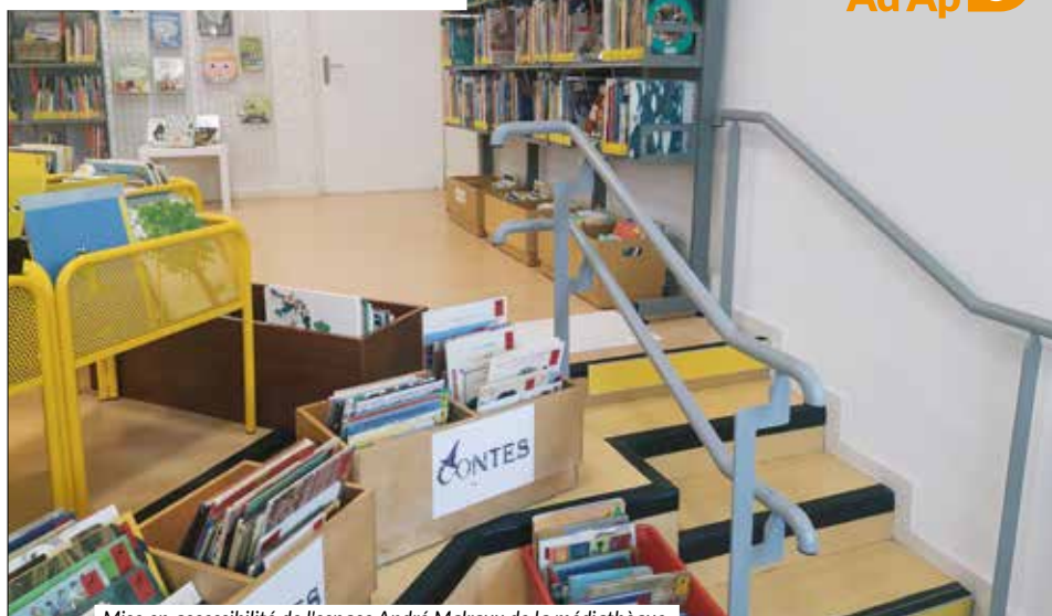
Mise en accessibilité de l'espace André Malraux de la médiathèque.
