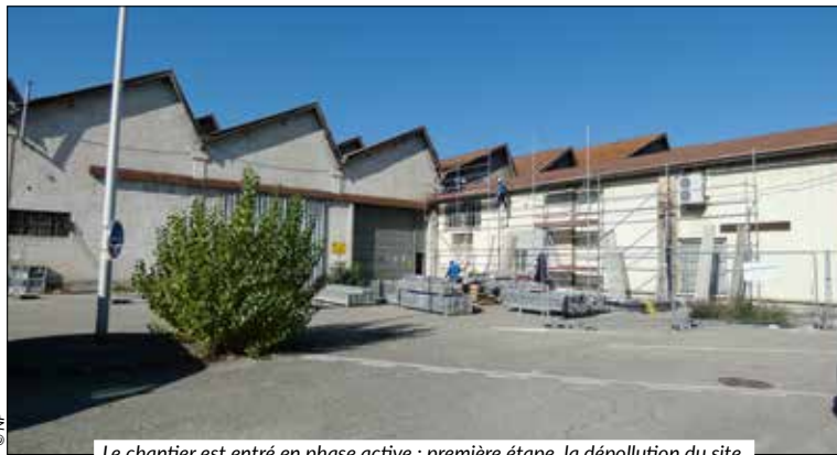
Le chantier est entré en phase active : première étape, la dépollution du site.
