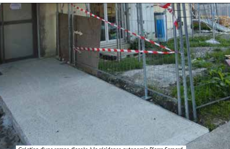
Création d'une rampe d'accès à la résidence autonomie Pierre Semard.
