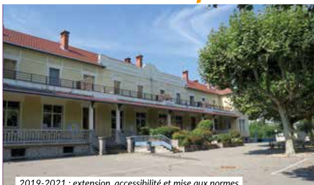
2019-2021 : extension, accessibilité et mise aux normes de l'école élémentaire Joliot-Curie.
