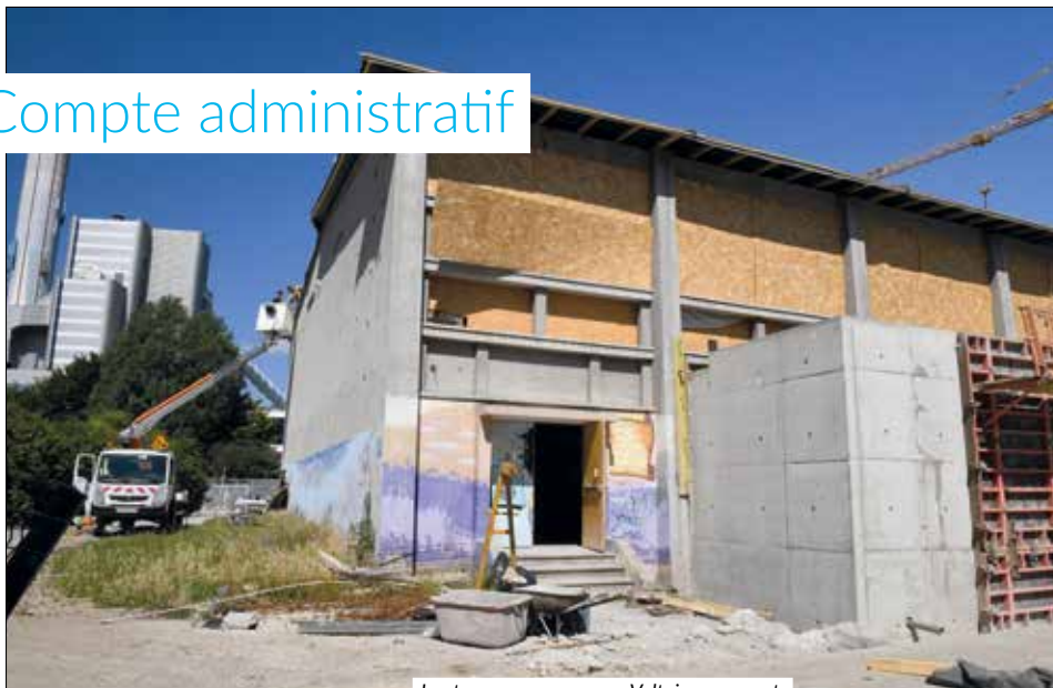
Les travaux au gymnase Voltaire avancent.
