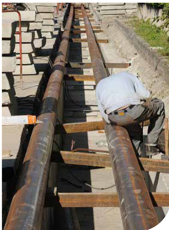
Installation du chauffage urbain
