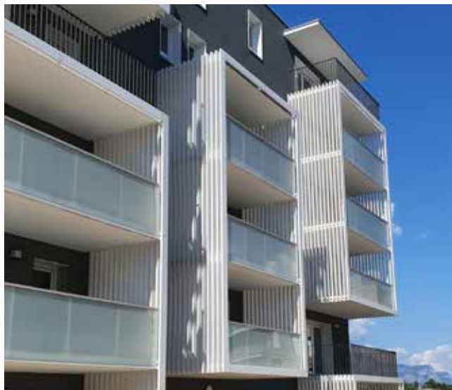
Intimité des logements entre eux, écoquartier Daudet, Saint-Martin-d'Hères
