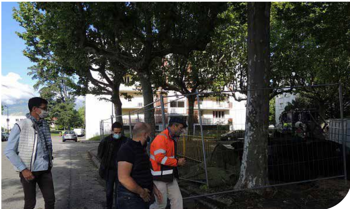
Visite du chantier place Louis Juvet, végétalisation et protection du vivant, Saint-Martin-d'Hères
