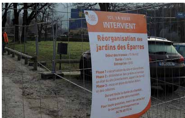
Chantier des jardins familiaux, résidence les Éparres, Saint-Martin-d'Hères
