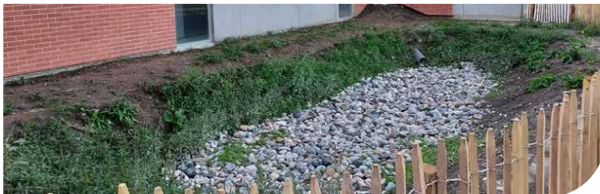
Noue paysagère - écoquartier Daudet, Saint-Martin-d'Hères
