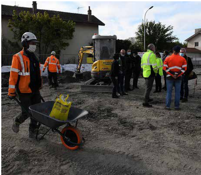
Visite du chantier Neyrpc
