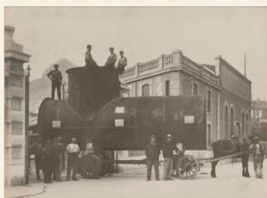
Sortie d'une conduite forcée de l'usine Joya, rue Nicolas Chortier à Grenoble.
