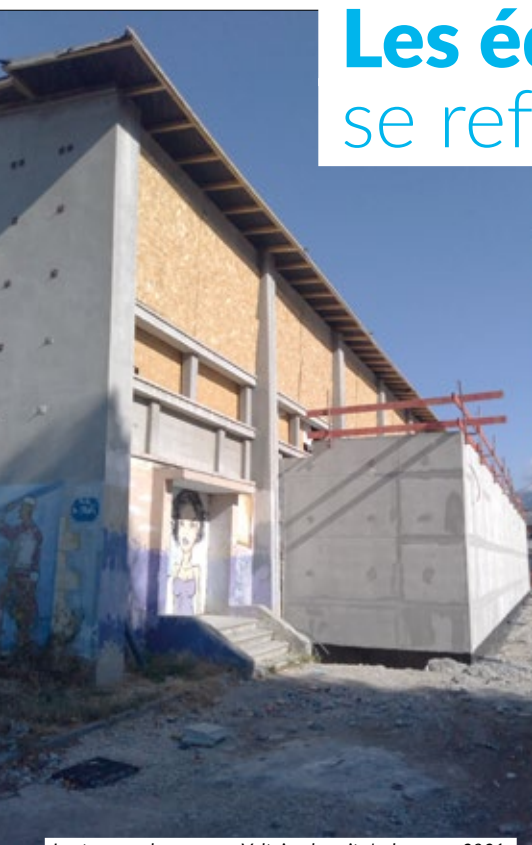
Les travaux du gymnase Voltaire devrait s'achever en 2021.
