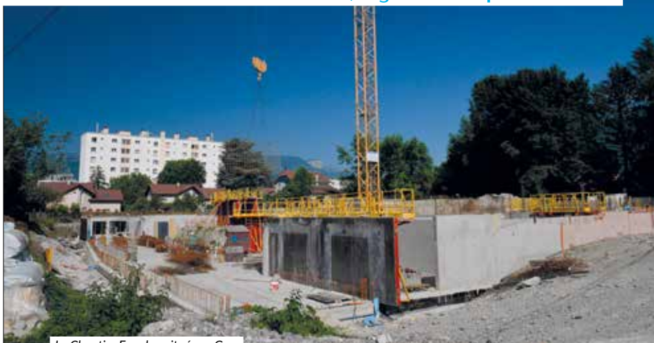
Le Chantier Equalys, situé rue Gay.
